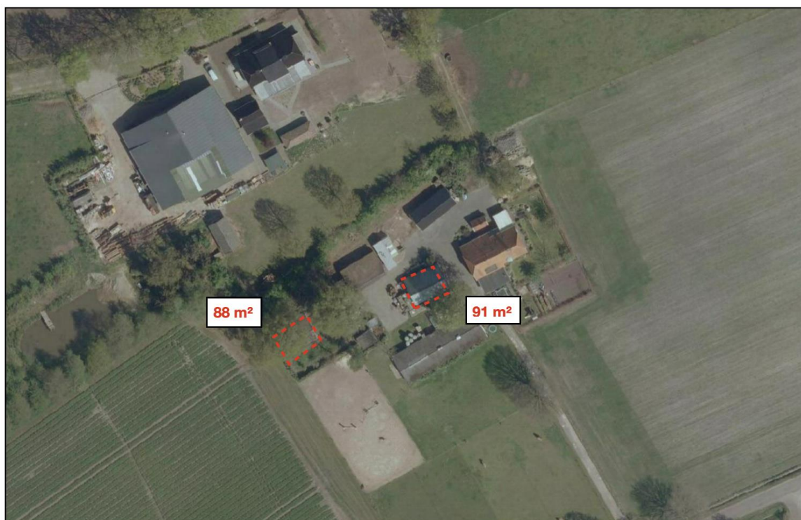
Afbeelding 2.3 Te slopen bebouwing plandeel Notterweg 4 (Bron: Provincie Overijssel)
