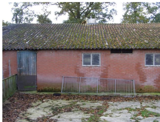
Afbeelding 4: een van de te slopen varkensschuren.
