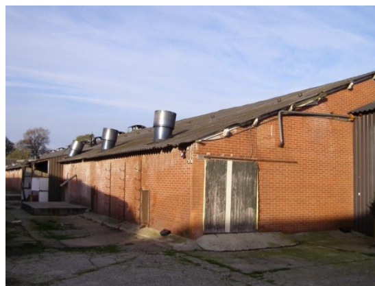
Afbeelding 3: een van de te slopen varkensschuren.
