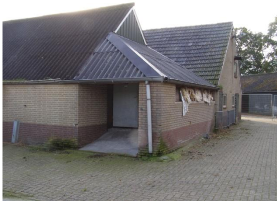
Afbeelding 4: een van de te slopen varkensschuren met deels pannendak
