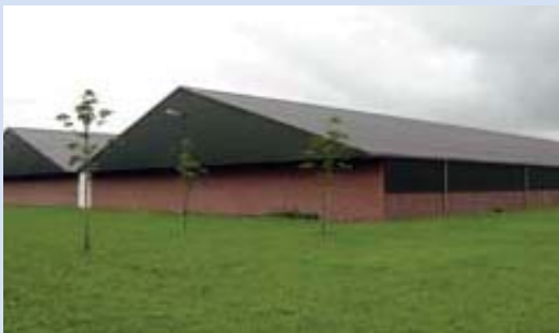
Rustige uitstraling gevels
