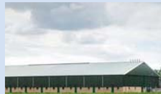
Lichte daken, tweedeling muren
