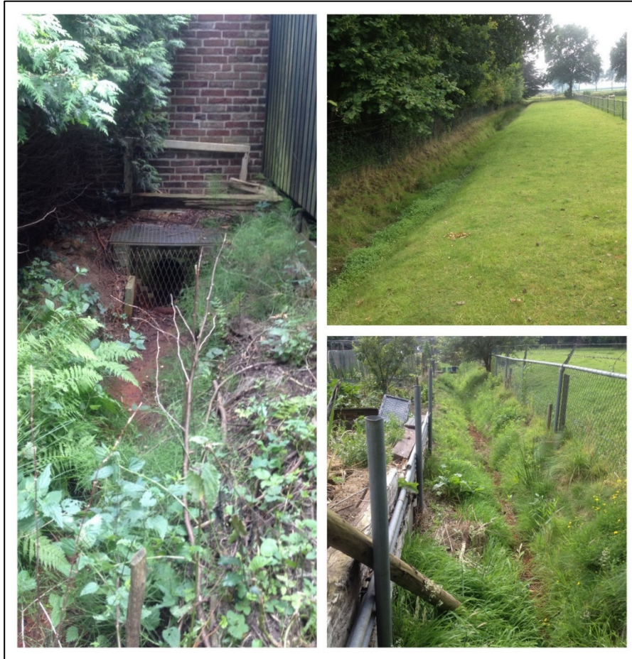
Figuur 12 Greppels en duiker aan de oostzijde van het plangebied. Rechtsboven greppel ter plaatse van schapenweide, rechtsonder greppel moestuin en links de afwatering in de duiker
