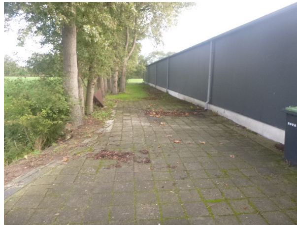
Westzijde opslaghal en houtwal
