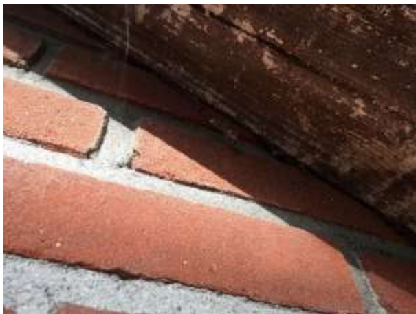
De betimmering van het dakoverstek van de schuren sluit naadloos aan op de buitengevels
