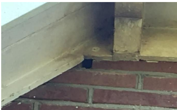
Potentiële invliegopening van vleermuizen.
