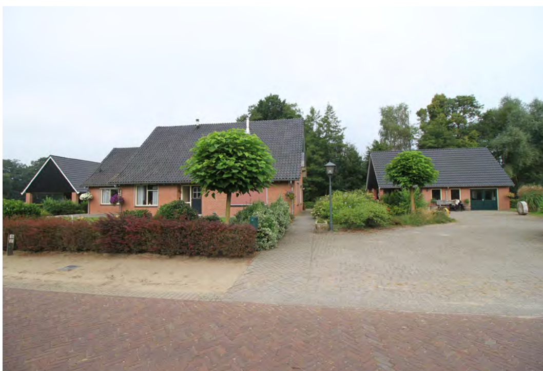
Afbeelding 4. De al ontwikkelde locatie Manderseweg 3, geen restanten sloop meer aanwezig
