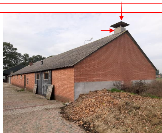
Foto 12 | Foto voor bron Ventilatie koker op het dak
