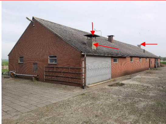
Foto 11 | Foto voor bron Ventilatie koker op het dak
