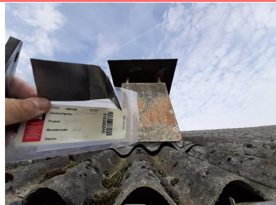
Foto 14 | Foto voor bron Ventilatie koker op het dak
