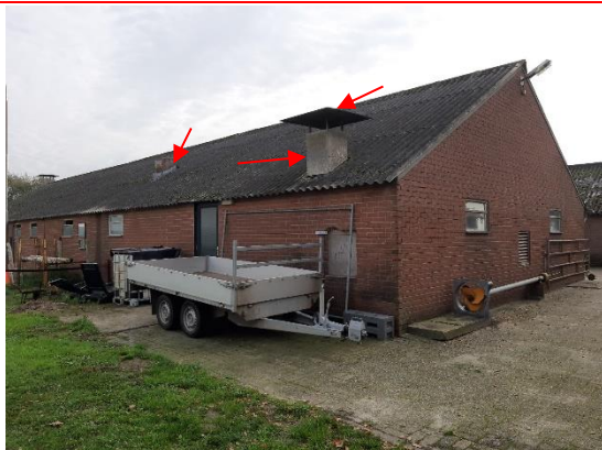
Foto 13 | Foto voor bron Ventilatie koker op het dak
