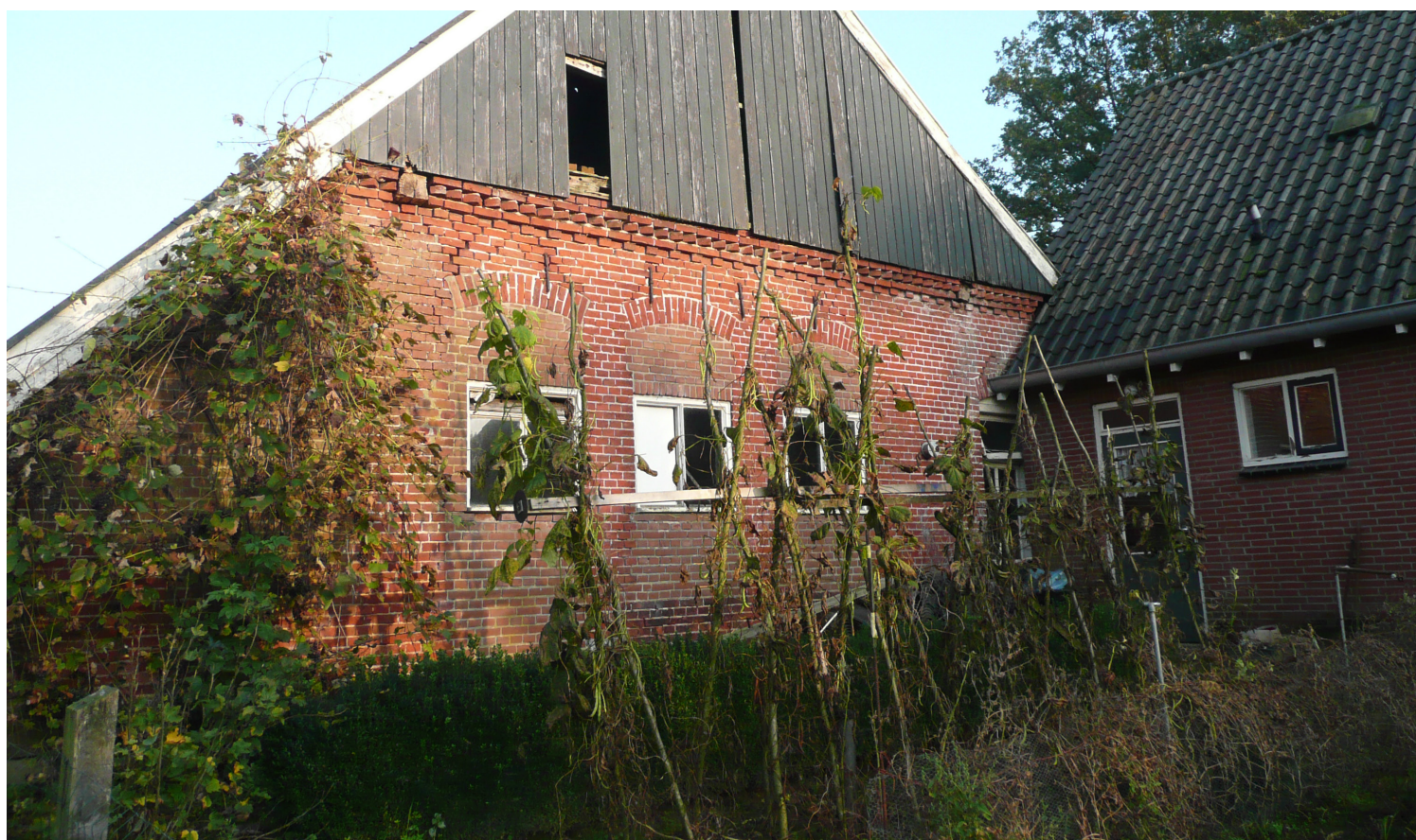
Afbeelding 6. Te slopen oude bedrijfswoning (rechts) en te behouden karakteristieke boerderij (links)
