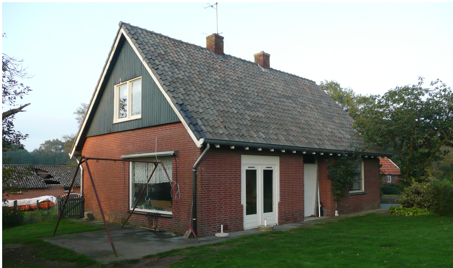
Afbeelding 5. Te slopen oude bedrijfswoning
