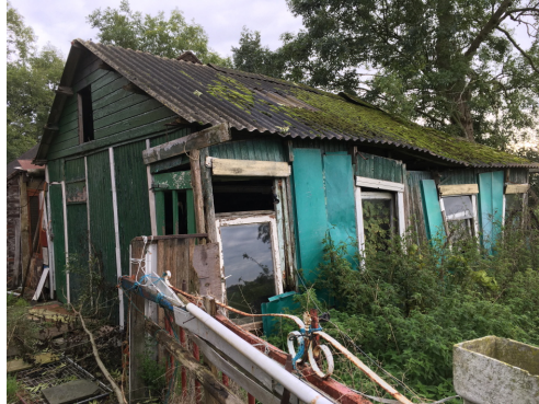
Figuur 9. Schuur aan de zuidzijde van het erf aan de Rechterensweg (gebouw a).
