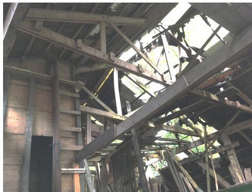
Figuur 11. Stal/schuur aan de noordoostzijde van het erf aan de Rechterensweg (gebouw d).
