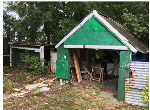
Figuur 12. Schuurtjes in de noordwesthoek van het erf aan de Rechterensweg (gebouw f en g).
