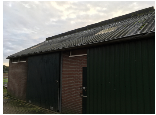
Figuur 5. Schuur/stal achterin het perceel aan de Zwarteveenweg (gebouw c).
