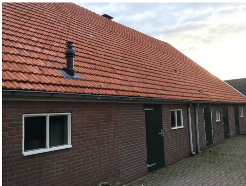
Figuur 6. Voormalige deel van de woning (gebouw a).
