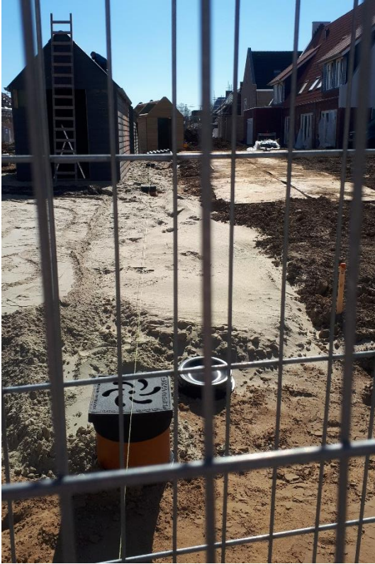
Hemelwaterafvoer achtertuinten naar achterpad.
