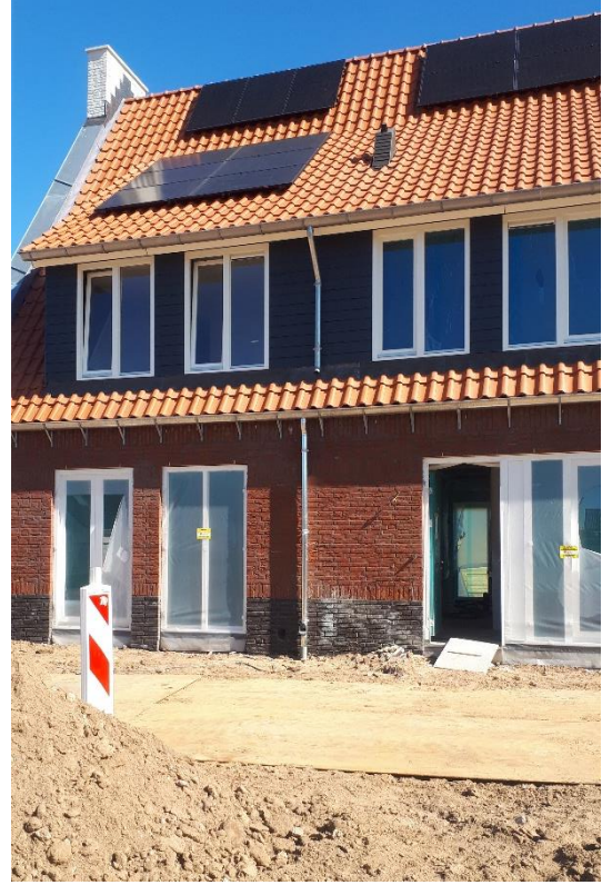
Hemelwaterafvoer voortuin bouw.
