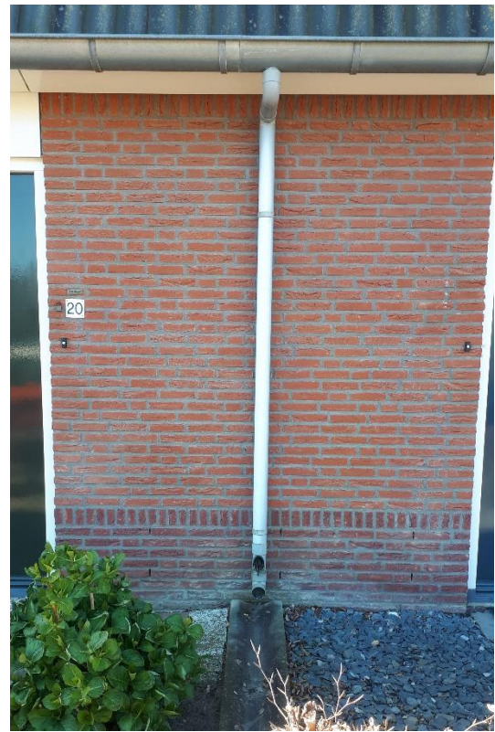
Hemelwaterafvoer dak in een goot voortuin.
