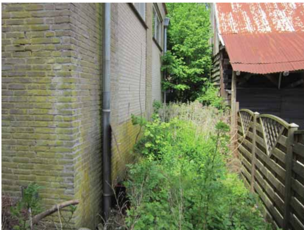
Terreindeel A; voormalig ketelhuis
