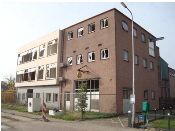
Figuur 3. Voorzijde fabriekscomplex.
