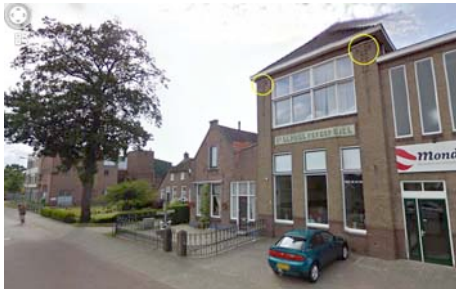
Figuur 13. Voormalige schoolgebouw met open stootvoegen (cirkels). Links op de foto het fabrieksgebouw.
