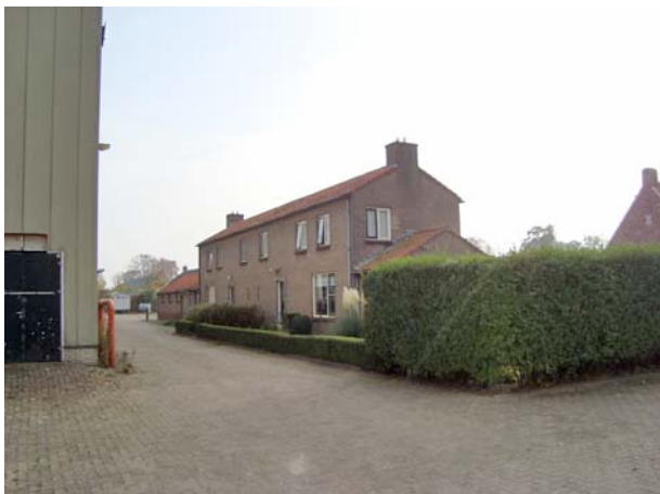
Figuur 5. Woningrijtje in zuidelijke richting gezien. Het achterste deel inclusief de schuurtjes wordt eerst gesloopt.
