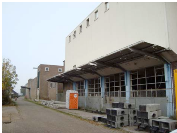
Figuur 4. Westzijde fabriekscomplex.
