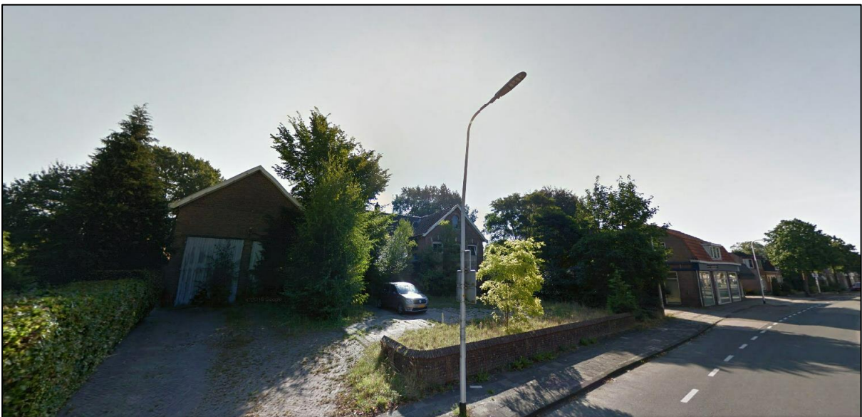
Afbeelding 2.3 Aanzicht plangebied vanaf de Dorpsstraat toen bebouwing er nog stond (Bron: Google Streetview)
