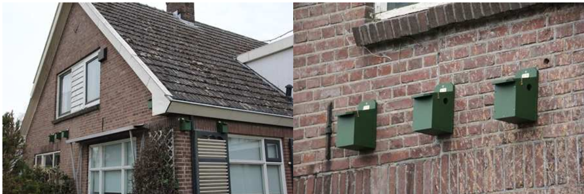
Recent bevestigde mussenkasten aan de te slopen woning.
