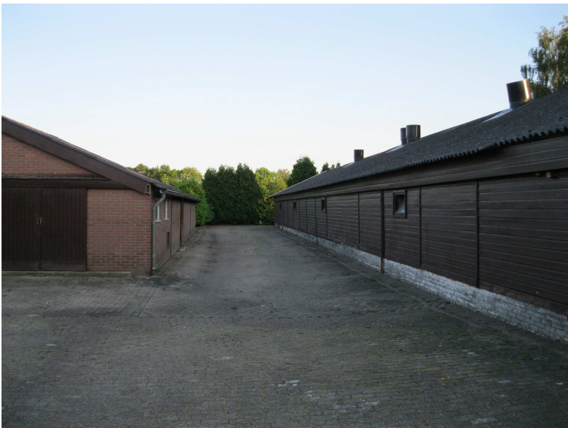
Figuur 3. Te slopen stallen
