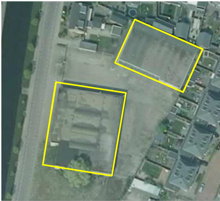
Detailopname van de twee onderzochte gebouwen
