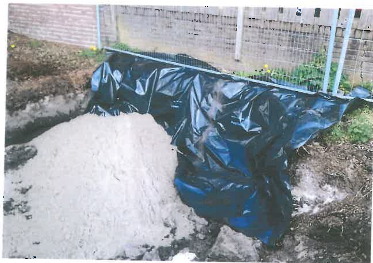
Foliewand ter plaatse van Burg. Kerssemakersstraat 7
