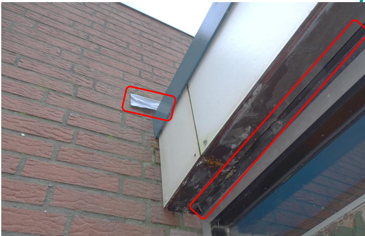
Figuur 5.5. Invliegopeningen tussen en onder de boeiranden en onder loodslabben geven toegang tot potentiële verblijfplaatsen.
