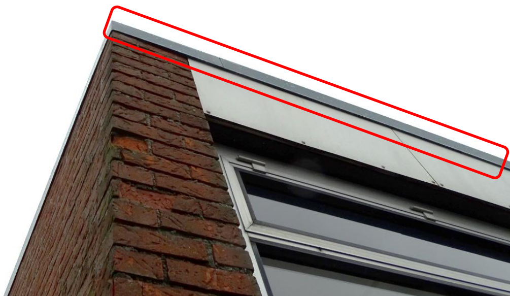
Figuur 5.6. Invliegopeningen onder de daktrim geven toegang tot potentiële verblijfplaatsen.
