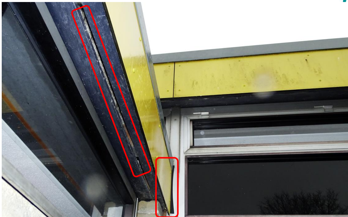
Figuur 5.3. Invliegopeningen tussen en onder de boeiranden geven toegang tot potentiële verblijfplaatsen.
