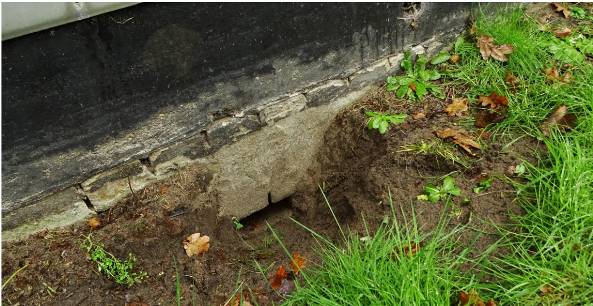
Figuur 5.2. Toegangsmogelijkheid naar een verblijfplaats voor de steenmarter onder de fundering van de school.
