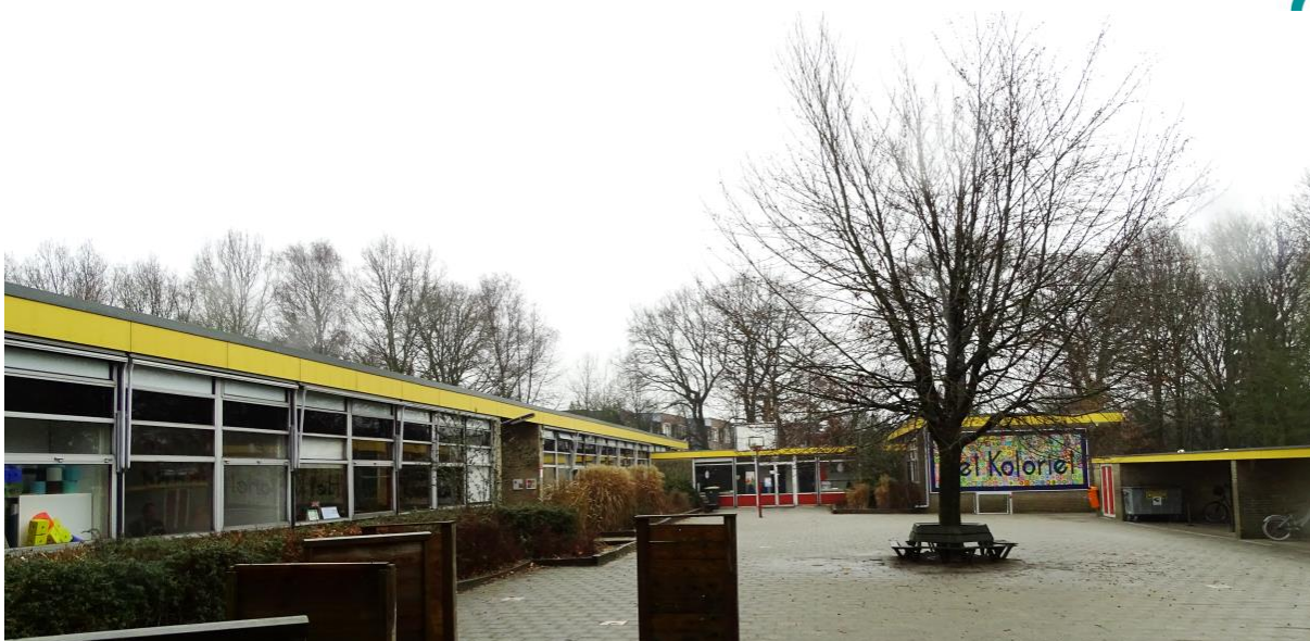
Figuur 2.2. Overzichtsfoto van de voorzijde van CBS Het Koloriet gezien vanuit zuidelijke richting.
