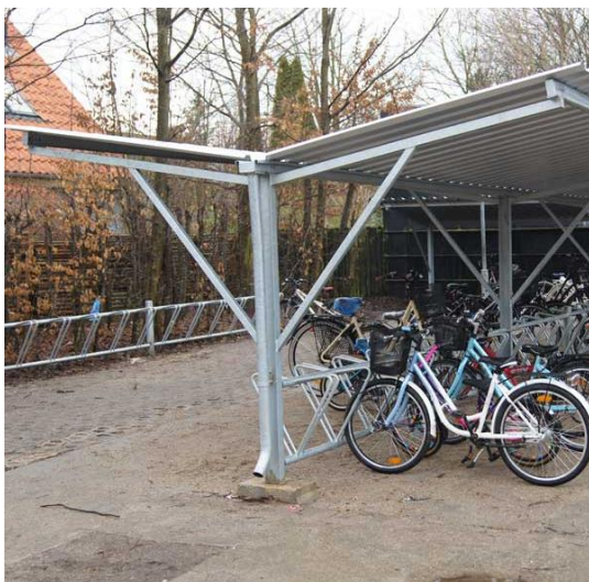
Figuur 37: Voorbeeld van een gebruiksvriendelijke en overdekte fietsenstalling (glazen overkapping zou de sociale veiligheid van de stalling ten goede komen)
