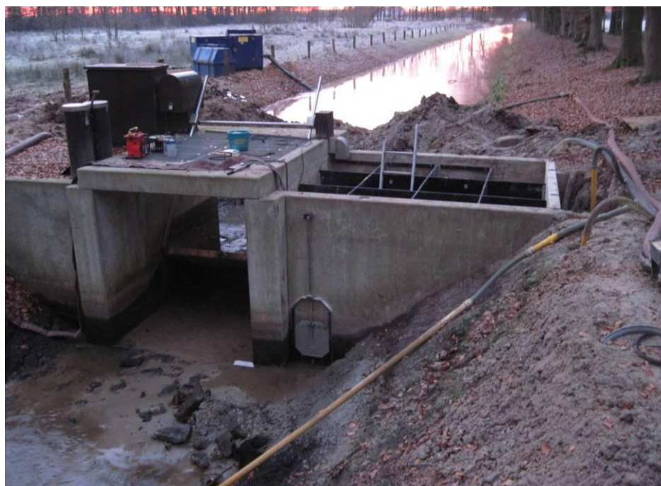
Figuur 6 De Wit passage in aanleg (Bron: EcoGroen Advies, Waterberging Emmertochtsloot).
