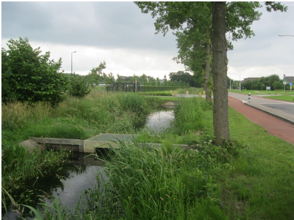
Figuur 2 Galgengraven met op de voorgrond een stuw en verderop een duiker onder de inrit naar het sportcomplex.
