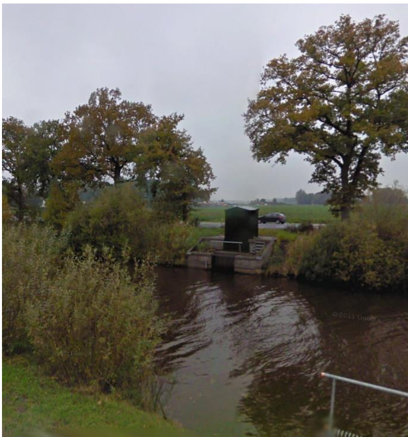
Figuur 2: Het gemaal Emsland vanaf de weg Ommerkanaaldijk Oost. Op de achtergrond is de N48 zichtbaar (bron: Google Streetview).
