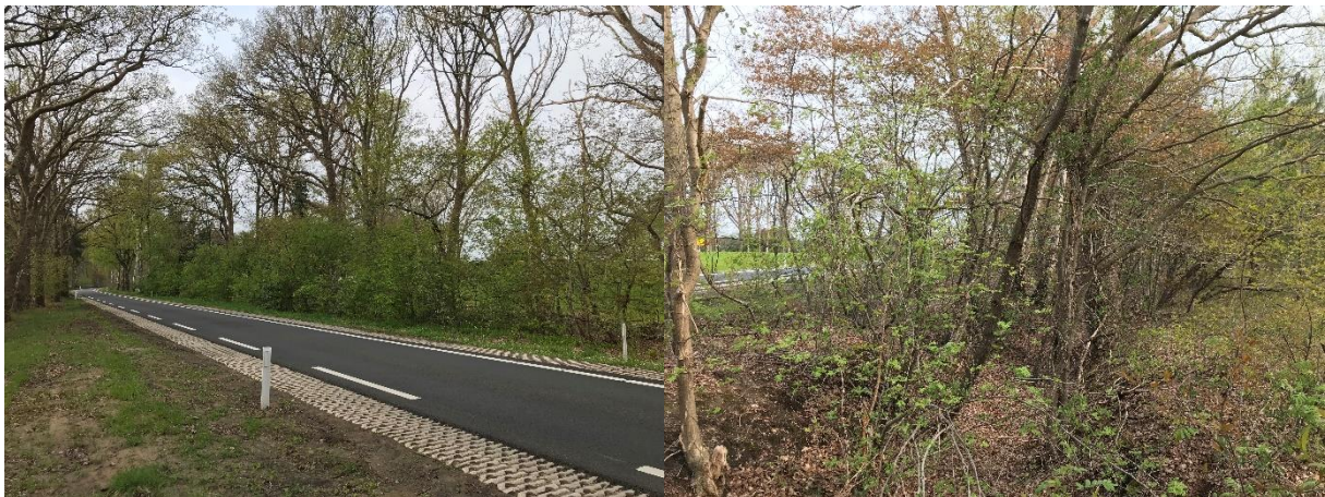
Afbeelding 3. c) De oprit van de N48 kijkend richting het zuiden en d) groenstrook ten oosten van de N48.
