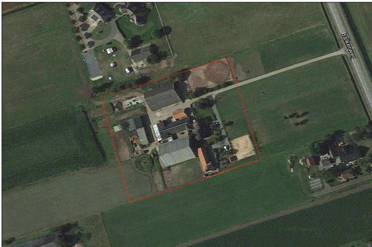
Afbeelding 2.2 Luchtfoto plangebied (Bron: Provincie Overijssel)
