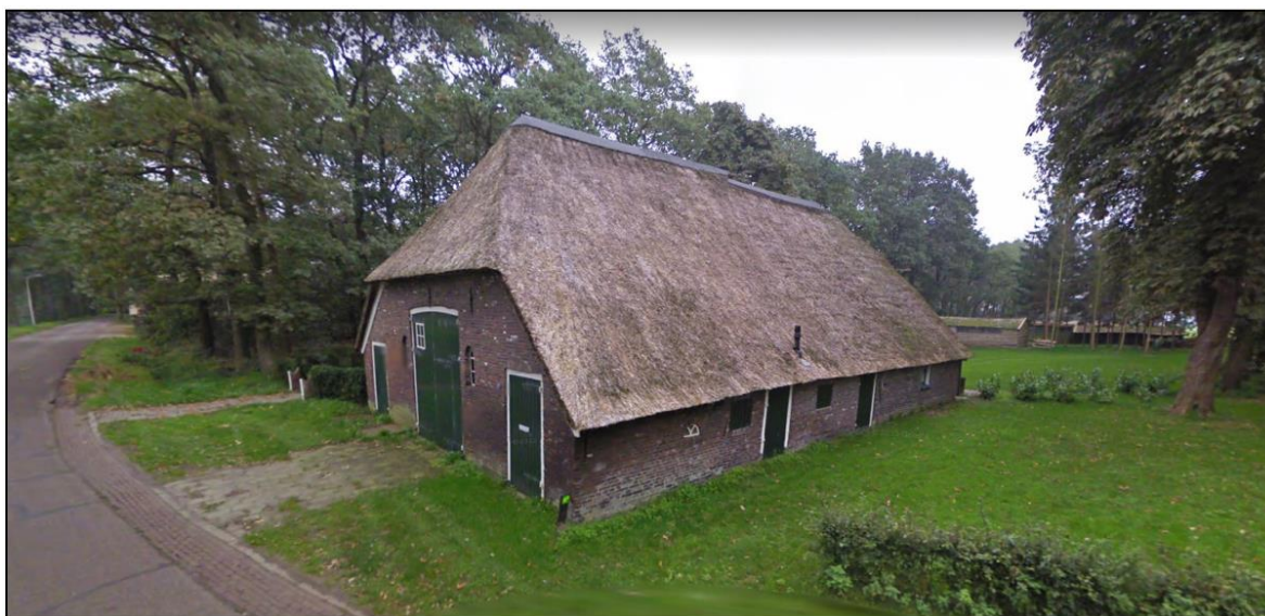
Afbeelding 2.2 Straatbeeld van het huidige verenigingsgebouw vanaf de Witharenweg (Bron: Google streetview, 2010)
