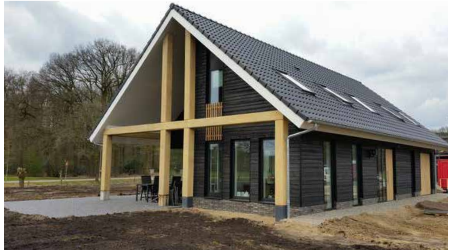
schuurwoning met detail (toepassing gebinten)
