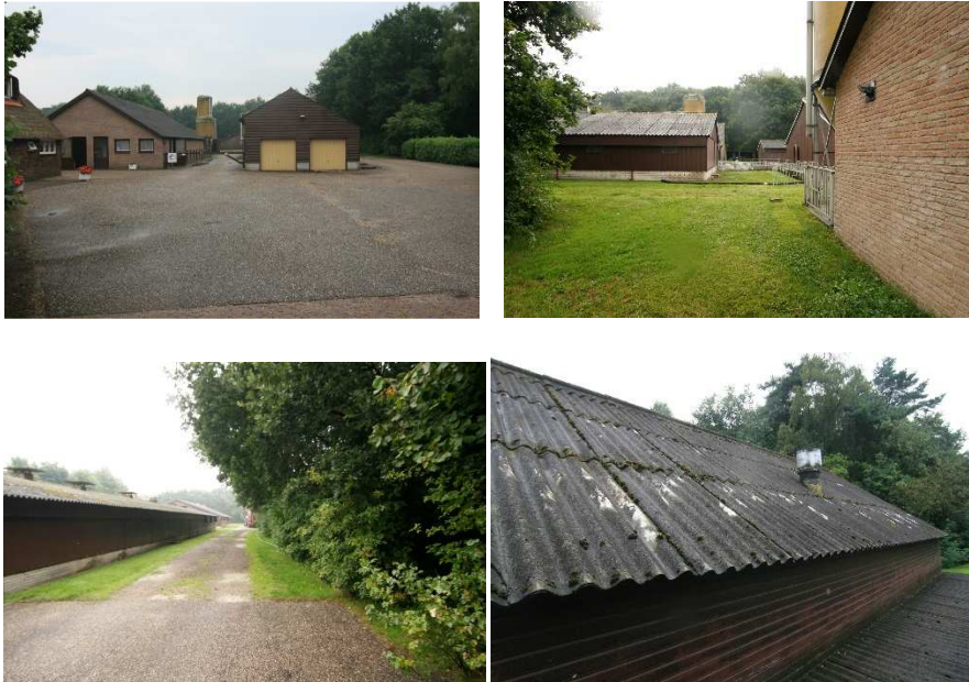
Te slopen schuur
