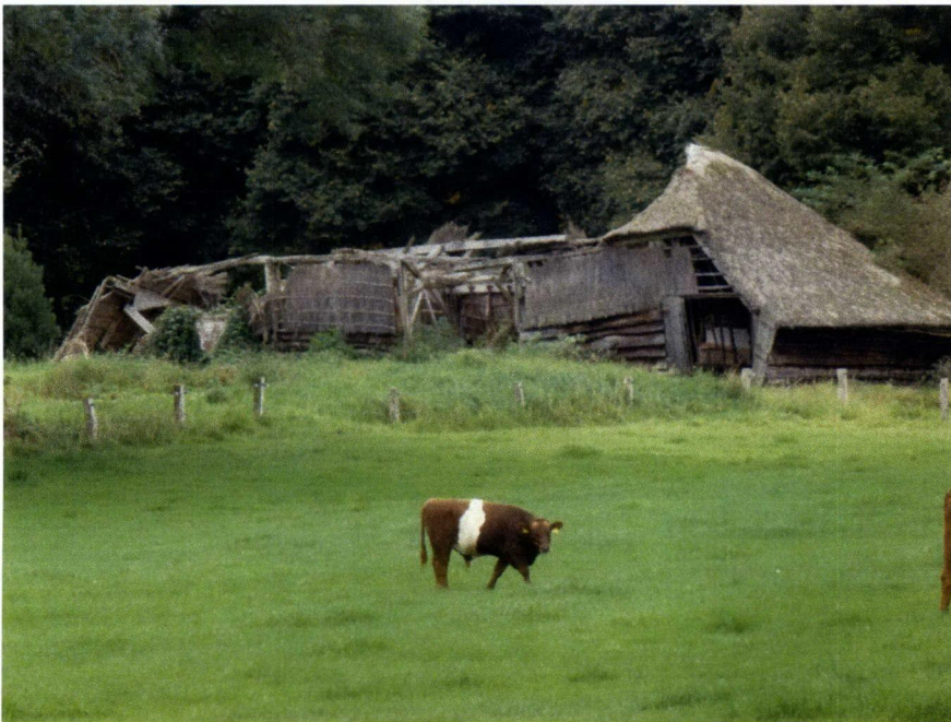
Foto 1: Vervallen boerderij. Aan de achterzijde is een schuurtje met een asbestverdacht dak aanwezig
