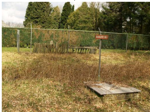
Ondergrondse infra thv gebouw B1
