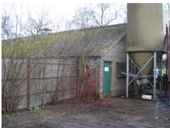
Figuur 3: Een van de te verwijderen varkensschuren met asbest golfplaten. Geïsoleerd met pur.
