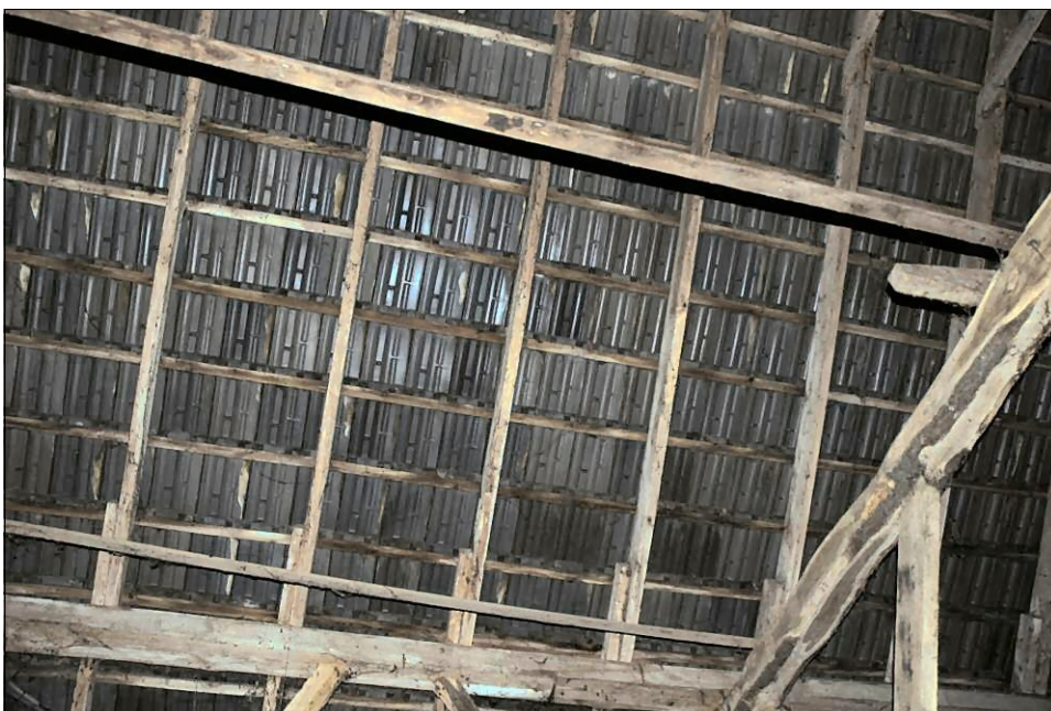
Binnenzijde pannendak houten schuur.
