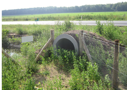
Foto 5 nieuwe weg ten zuiden van de projectlocatie waaronder meerdere dassentunnels zijn aangelegd.
