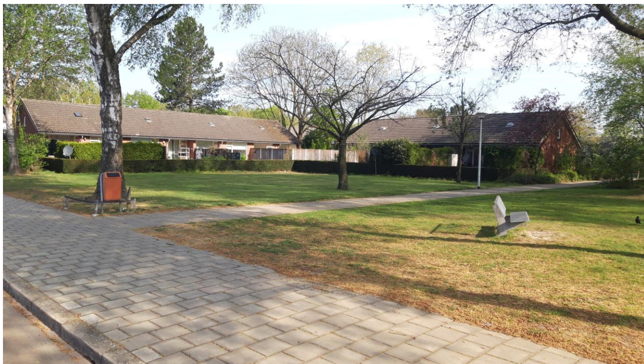
Foto 1: Overzicht locatie vanaf Jacob Catsstraat
