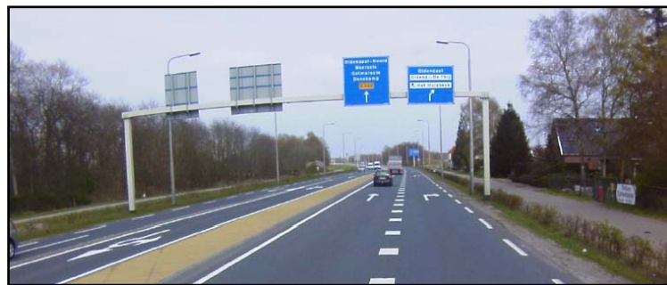
Foto 5.1: portaal ter hoogte van aansluiting Ossenmaat
