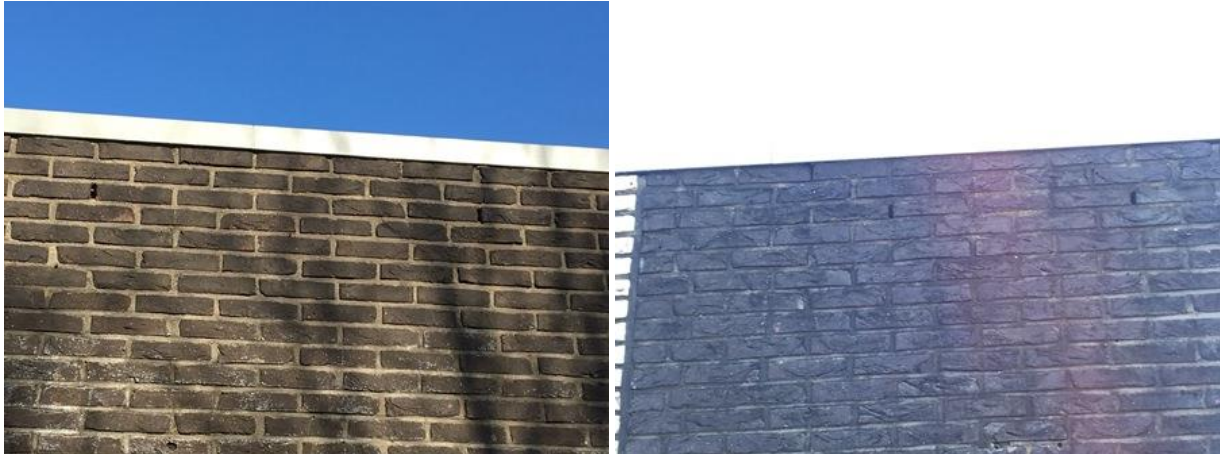
Openingen in de buitengevel bieden vleermuizen de kans een verblijfplaats te bezetten in de spouw.
