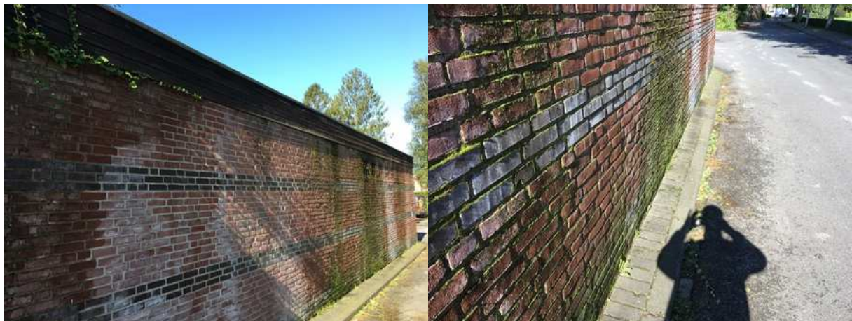
Dakplint aan het gebouw, géén sporen van de aanwezigheid van vleermuizen.
