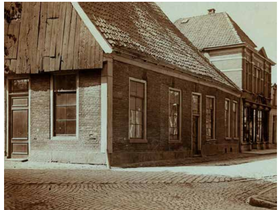
afb. 32 Deuningestraat 29, 29a en 31: Het kleine witte pandje Deurningestraat 29a maakte vroeger deel uit van het voormalige pand Deurningestraat 31. Zie bijgaande foto. Onder dit pandje bevindt zich een laat middeleeuws (?) souterrain met traptogang van binnenuit. Zie daartoe de beide kelderramen (bron: Jos Oude Essink Nijhuis).
