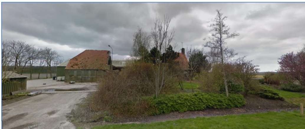
Fig. 3.2: Een weergave van de boerderij (bedrijfswoning) dat een gedeelte is ingestort.
