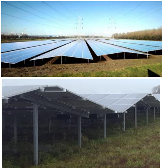
Figuur 3.3 Voorbeelden aanzicht panelen met oost-west oriëntatie
