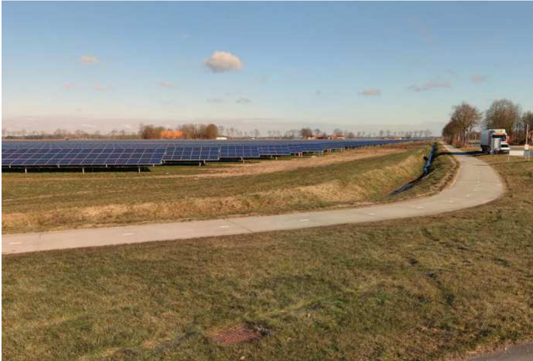
Zicht vanaf rotonde Kuinderweg (aansluiting op Dukaat)
