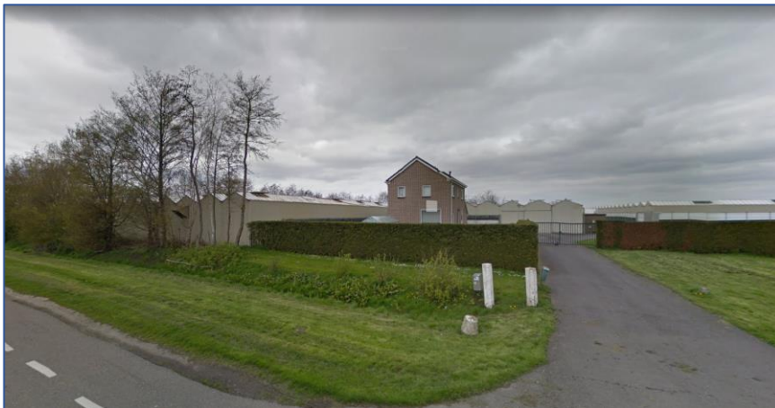
Figuur 6: zicht op de woning en stallencomplex nr. 28 (bron: Google Maps)
