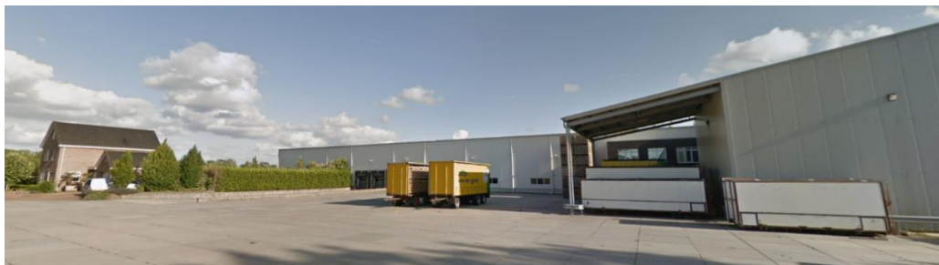
Figuur 3.7: Een weergave op de bedrijfsbebouwing en de bedrijfswoning op het perceel Kleiweg 4.
