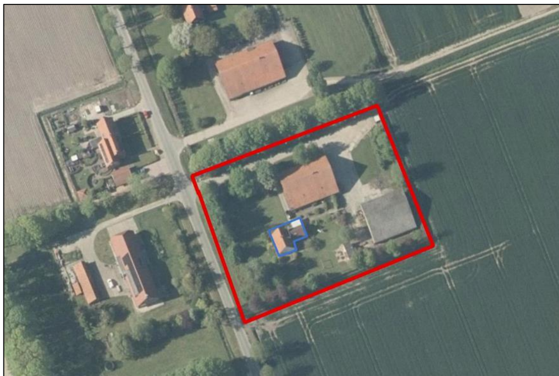
Afbeelding 2.1. Begrenzing van het plangebied (rood kader), het blauwe kader geeft de locatie van de te slopen bedrijfswoning aan. (Bron achtergrond: Esri)
