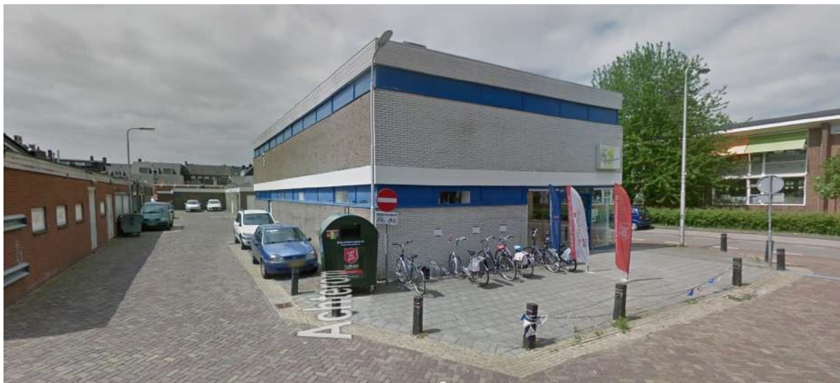
Figuur 2.3 Weergave huidige situatie projectgebied vanaf de achterom. Bron: Google Streetview, 2018
