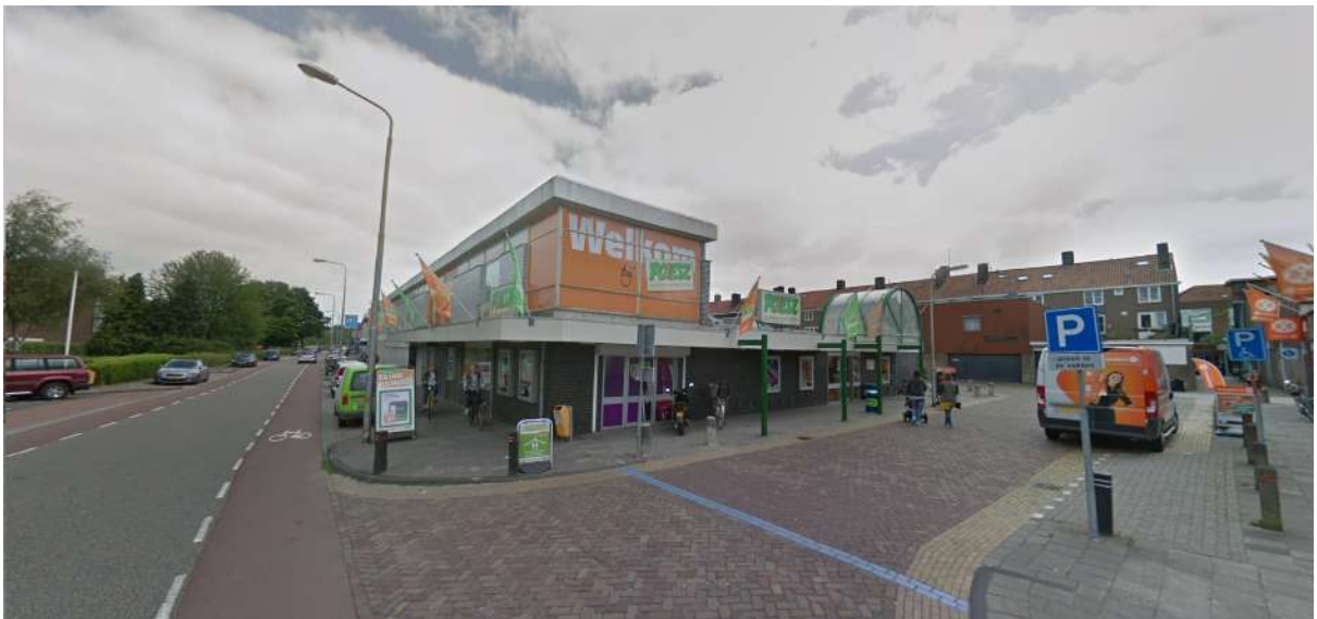
Figuur 2.2. Weergave huidige situatie projectgebied vanaf de Noordzijde. Bron: Google Streetview, 2018
