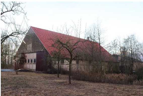
Foto 5: Achterzijde opslagloods met poeltje (rechts)
