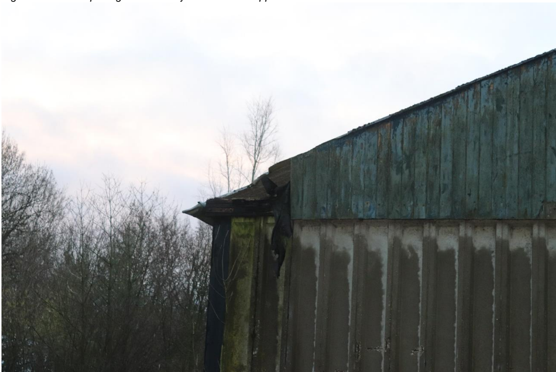
Figuur 3.3: Openingen dekpunten aardappelschuur.
