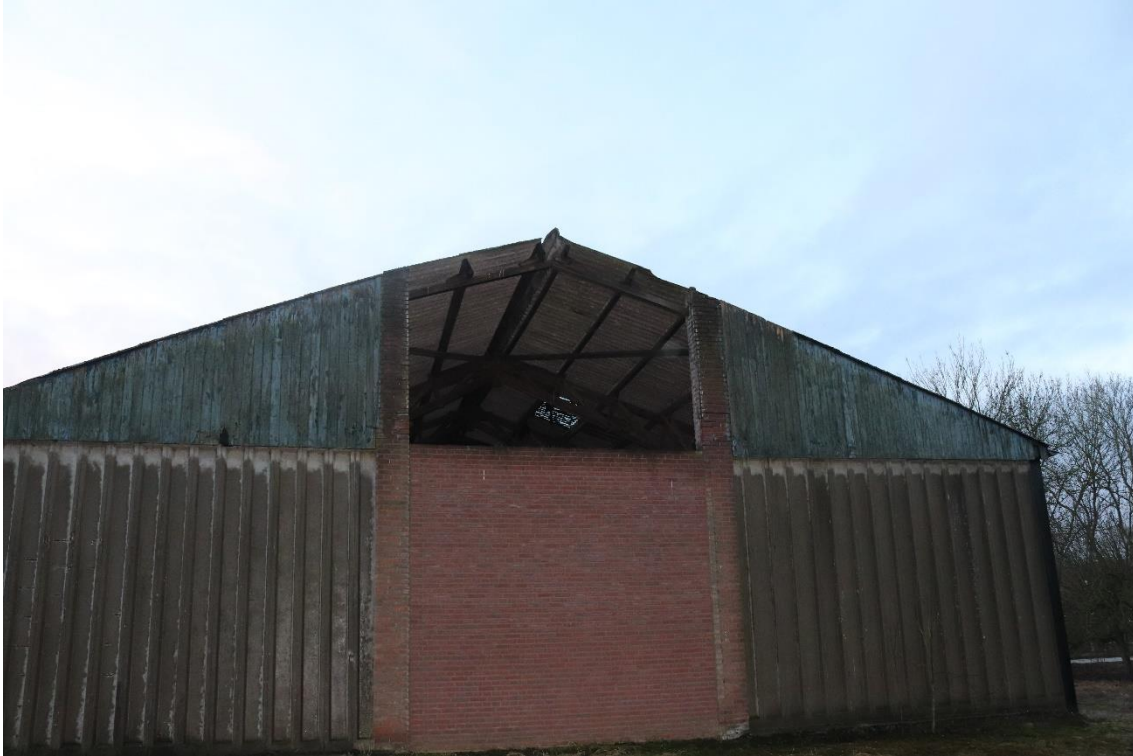
Figuur 3.2: Grote opening aan achterzijde van de aardappelschuur.
