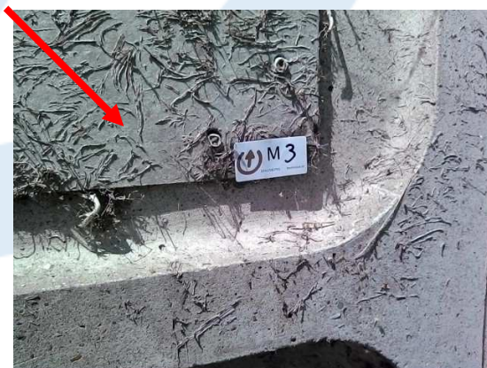
Foto 11 | Afdichting gevel elementen
