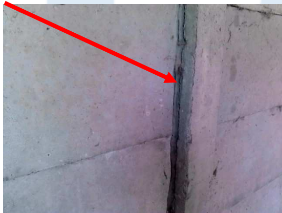
Foto 20 | Kit als afdichting tussen palen en schotten
