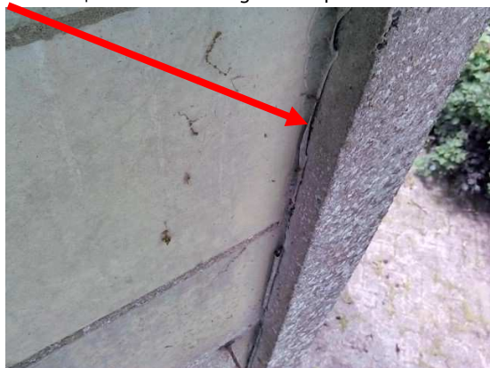
Foto 22 | Kit als afdichting tussen palen en schotten
