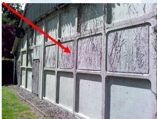
Foto 10 | Afdichting gevel elementen
