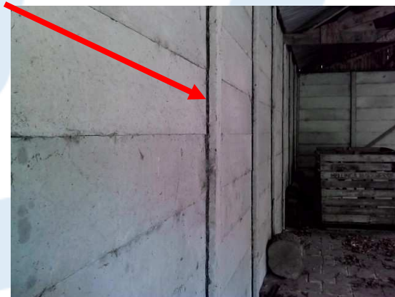
Foto 21 | Kit als afdichting tussen palen en schotten
