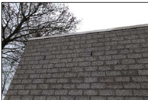
Foto 3. Spouwmuur in gebouw van biljartvereniging in noordoosten van plangebied
