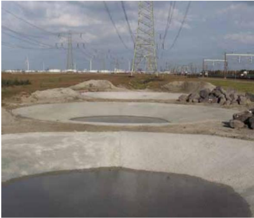
Figuur 4 Voorbeeld aanleg poelen voor rugstreeppad in de Rotterdamse haven. Voor het realiseren van geschikte en makkelijk te schonen poelen is gebruik gemaakt van betonnen bakken. In de directe omgeving zijn hopen zand en stenen geplaatst.
