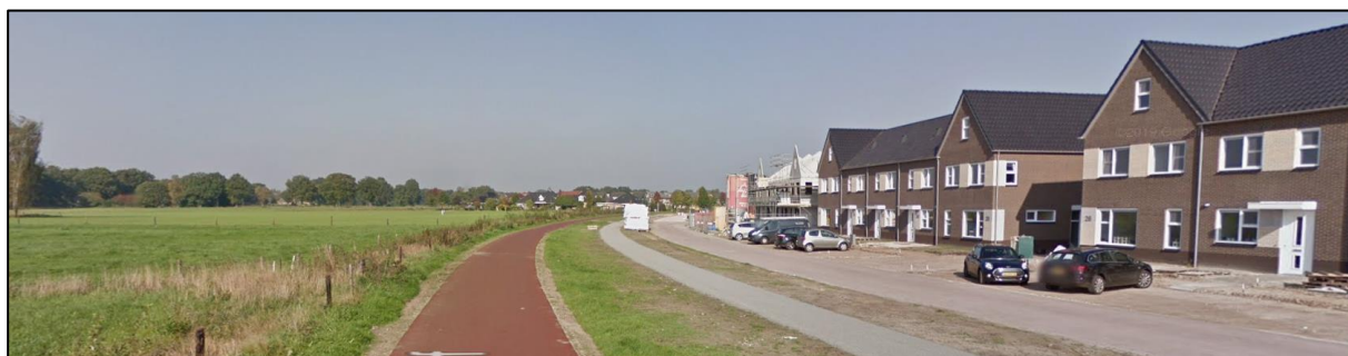
Zicht op het Sallers-Kerkpad. Aan de linkerzijde het plangebied dat hier nog niet in ontwikkeling is genomen. Recht gerealiseerde woningen.
